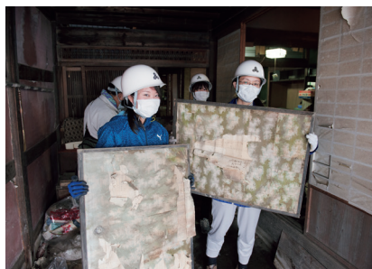
②解体される明治期の商家からの資料保全 (2016 年 4 月)
