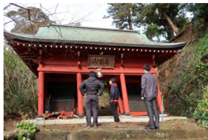
②台風 15 号被害に対する自治体との合同調査 (2019 年)
