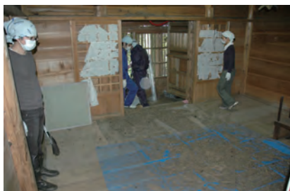
⑤ 堂内に降り積もる塵の元となっていた屋根裏に山積していた塵を清掃する
